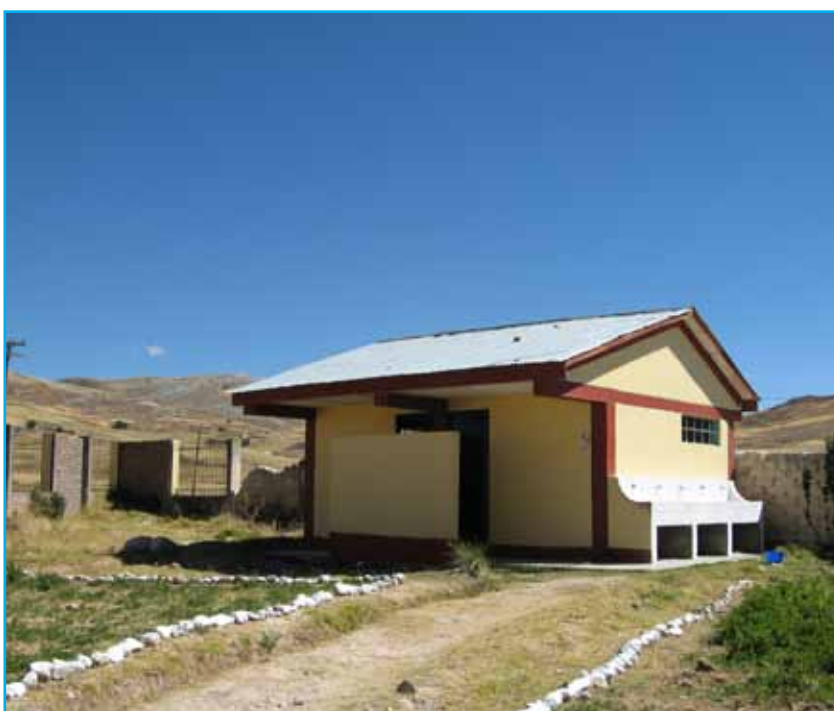
Inodoros para niños con una estación para el lavado de las manos en una escuela.
